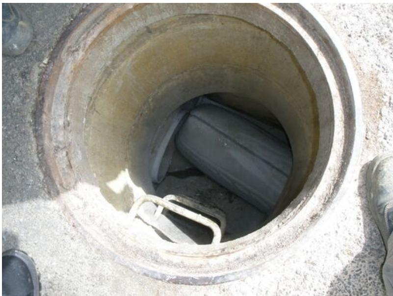
Une nouvelle paroi intérieure est insérée dans les conduites endommagées.
