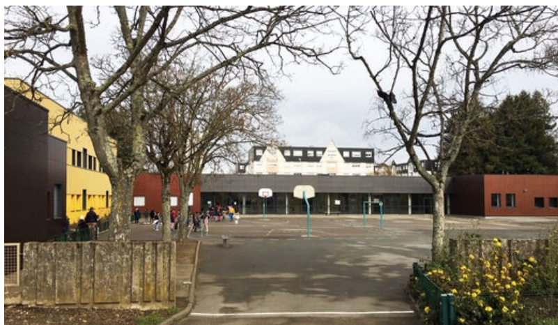
L'école primaire de l'Épau a été entièrement rénovée. © Ville du Mans
