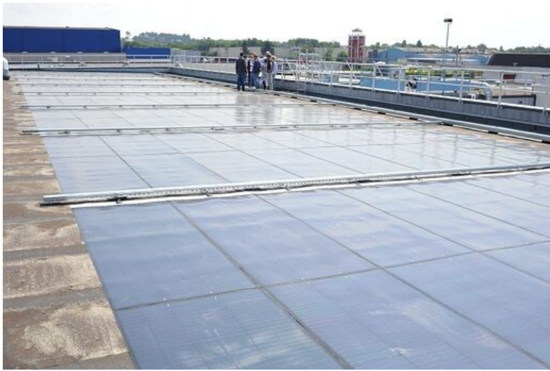
La production d'énergie solaire sur le territoire de Le Mans Métropole s'est élevée à 39,4 GWh en 2024 contre 13,3 GWh en 2018. © Ville du Mans
