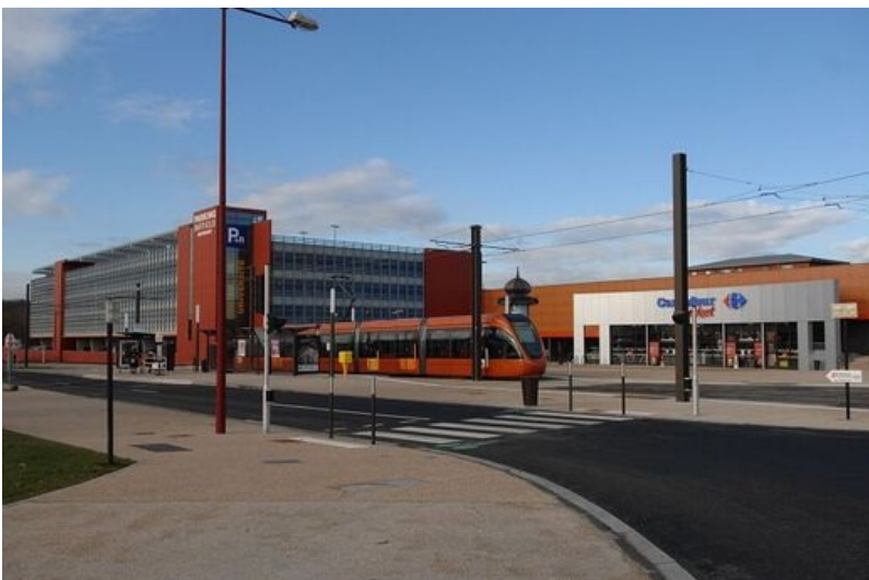
Terminus de la ligne 1 du tramway.
